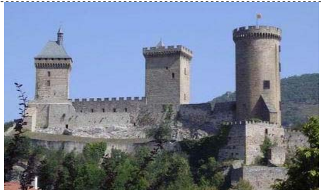
Château de Foix – 7 ème siècle Château difficile d'accès avec peu de fenêtres
